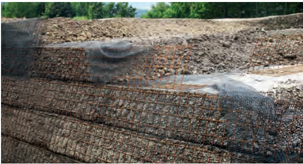
Meshes for reinforced soils / Reti per terre armate / Matten für Stahlboden
