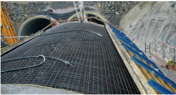
Meshes for tunnels / Reti per gallerie Bewehrungsgitter für Tunnel
