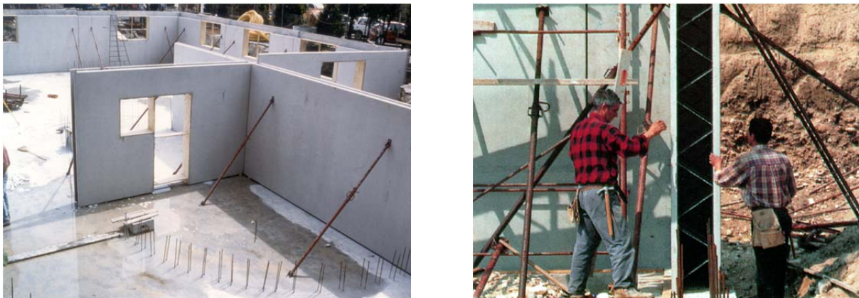
Figure 8: Opérations d'assemblage de mur préfabriqués en béton.
