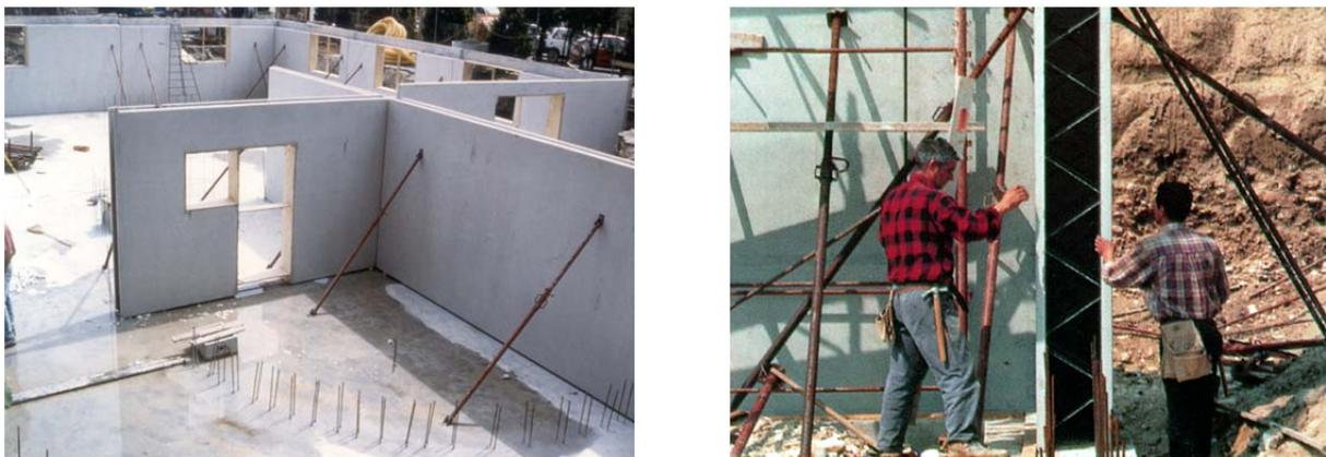
Abbildung 8: Montage der Fertigteilwände.
