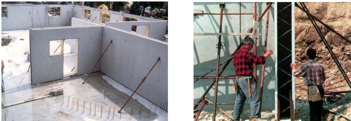
Σχήμα 8: Εργασίες συναρμολόγησης προκατασκευασμένου τοιχώματος.
