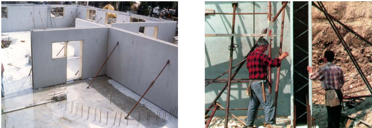
Figura 7: Operazioni di assemblaggio delle pareti.
