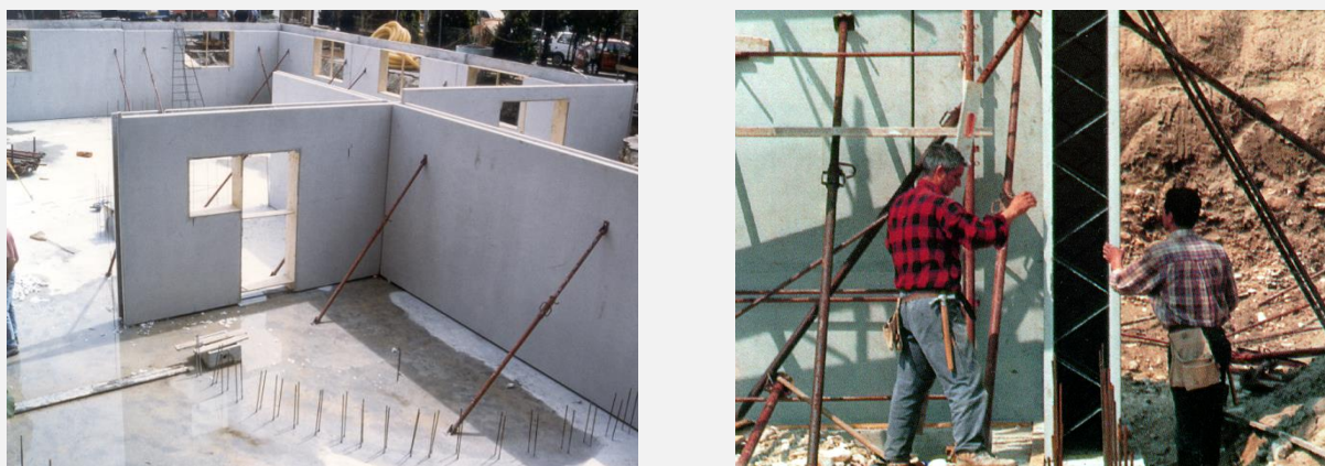
Figura 8: Montajul ansamblului de perete din b.a. prefabricat.
