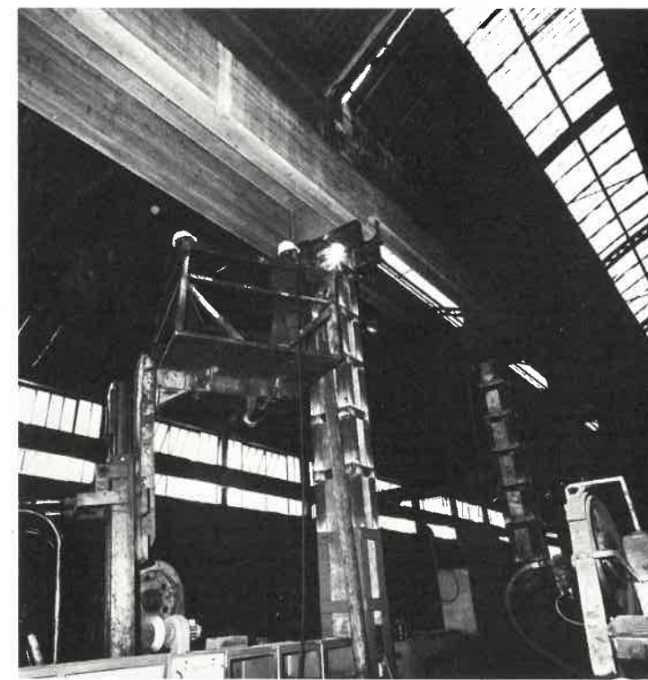
Tutte le strutture sono risultate notevolmente danneggiate tanto da dover essere rinforzate con forti intelaiature d'acciaio in modo tale che in seguito, oltre agli sforzi della normale attività (vibrazioni, corse dei carri-ponte ecc.), potessero far fronte, come strutture antisismiche, anche alla violenza di nuovi terremoti.
