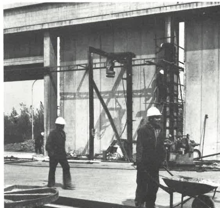
La riparazione delle strutture portanti degli stabilimenti è stata portata a termine a regola d'arte, tanto che con la ripresa del terremoto di metà settembre esse hanno potuto resistere egregiamente a una violenza uguale a quella della sera del 6 maggio.
