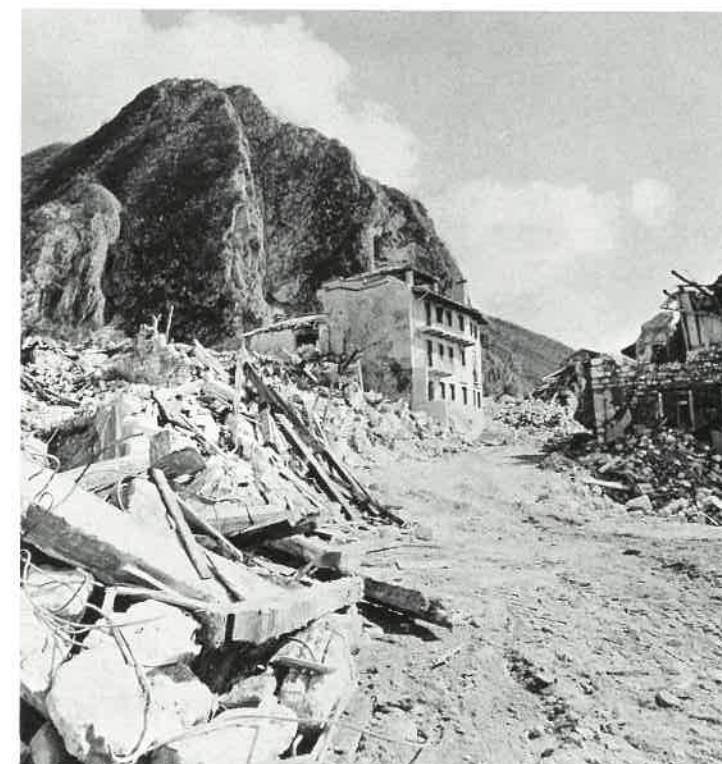
Nella foto grande: una panoramica dell'area su cui sorgono le industrie del Gruppo Pittini ad Osoppo. Le macerie sono state completamente sgombrate e già iniziano le opere di rifacimento delle strutture e delle coperture. Qui sopra: quello che è rimasto di una parte del centro storico di Gemona — la "capitale" del terremoto — dopo la ripresa delle scosse del 15 settembre.
