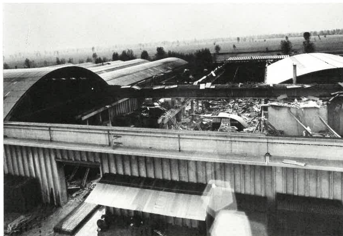
Alle prime luci dell'alba del 7 maggio gli stabilimenti del Gruppo Pittini — tra i più colpiti della zona industriale di Osoppo e nei quali avevano perso la vita 7 lavoratori — evidenziavano, con la drammaticità della distruzione totale, l'enorme lavoro che avrebbe dovuto esser compiuto per la rinascita. Il laminatoio (foto grande nelle due pagine precedenti) e i reparti di trafilatura e di elettrosaldatura della Ferriere Nord (foto sopra) risultavano completamente distrutti, dato che anche le strutture rimaste in piedi erano state compromesse in modo irreparabile. In situazioni analoghe si vennero a trovare anche gli stabilimenti della Impianti Industriali SpA ad Osoppo, della Siat SpA a Gemona del Friuli e i fabbricati, in fase di ultimazione, della Assa SpA di Majano.
