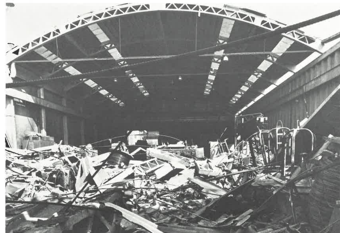
Degli impianti che producevano i laminati a caldo (qui sopra) e di quelli relativi alla produzione di armature elettrosaldate (foto sotto) ben poco s'è riuscito a salvare per l'allestimento delle nuove linee di produzione. I pochi macchinari recuperati sono stati comunque rimessi in grado di funzionare in officine di fortuna e quindi rimontati con i nuovi impianti.
