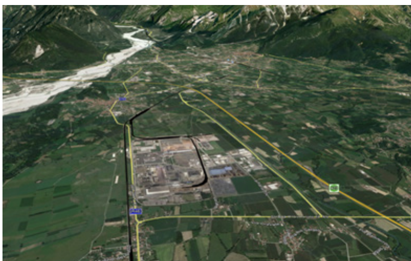
Figura 11.1 – Veduta aerea delle reti viarie principali
