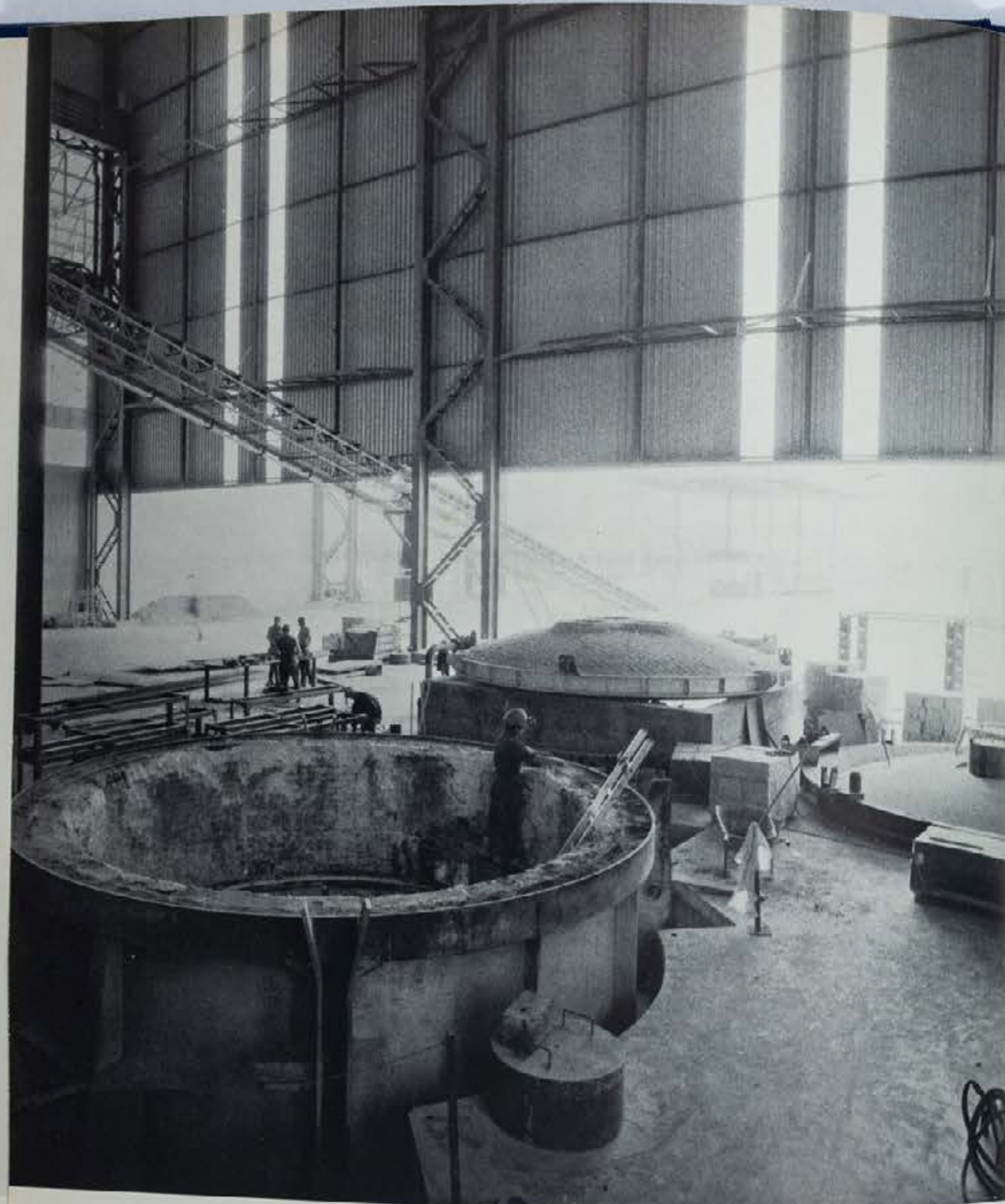
Ripristino dei rivestimenti refrattari
