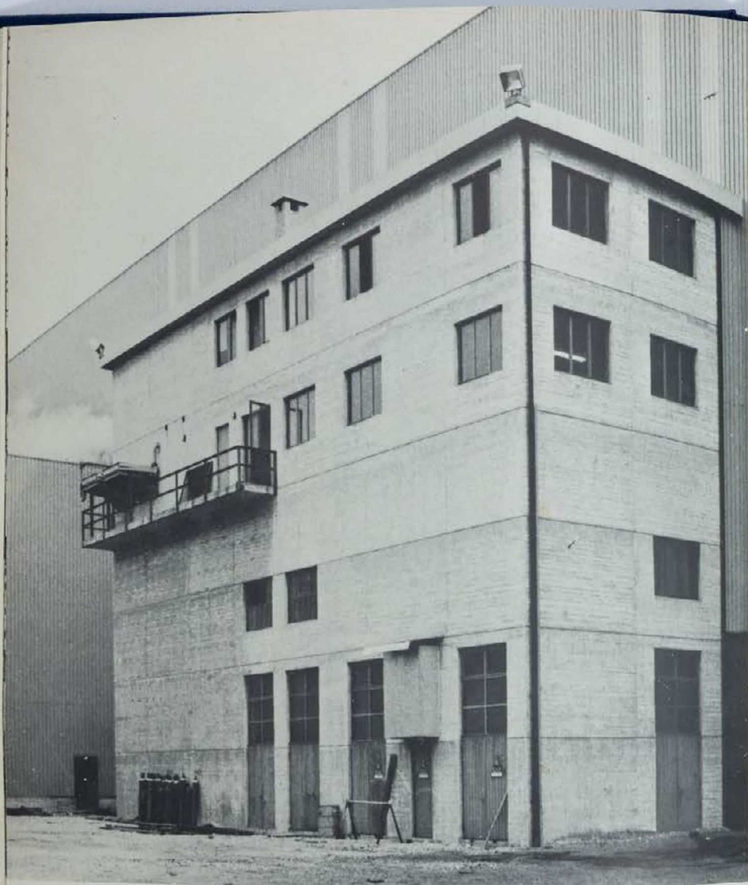
Edificio della cabina elettrica
