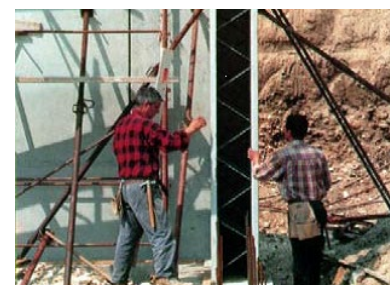
Doppia lastra tralicciata e armatura per setto
