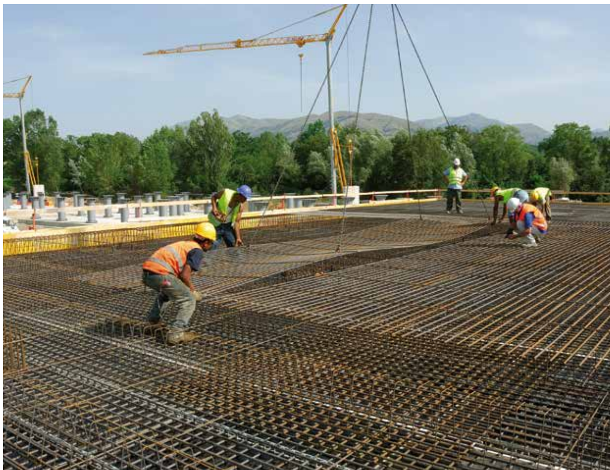
Piastre di fondazione per il progetto C.A.S.E. (AQ) - Foundation slab for C.A.S.E. project (AQ)
