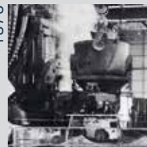
Costruzione dell'acciaieria di OSOPPO Building of steelwork in OSOPPO
