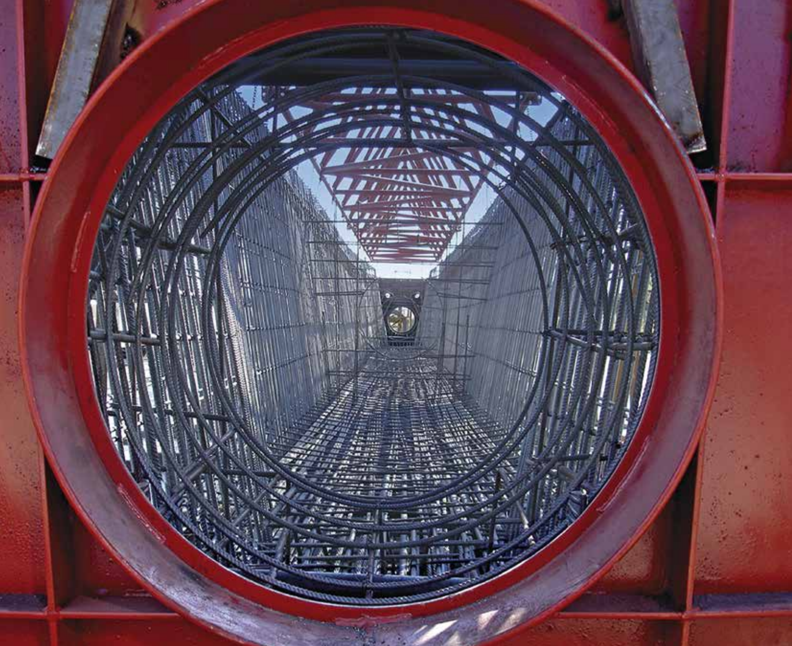
Autostrada A24 – Armatura trave del viadotto in Val Vomano - A24 Highway – Val Vomano Viaduct beam reinforcement
