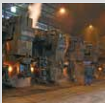
Costruzione laminatoio BARRE a Osoppo Construction of rebar mill in Osoppo
