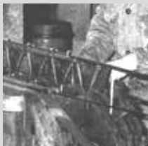
Inizia la produzione di traliccio Start lattice girder production
