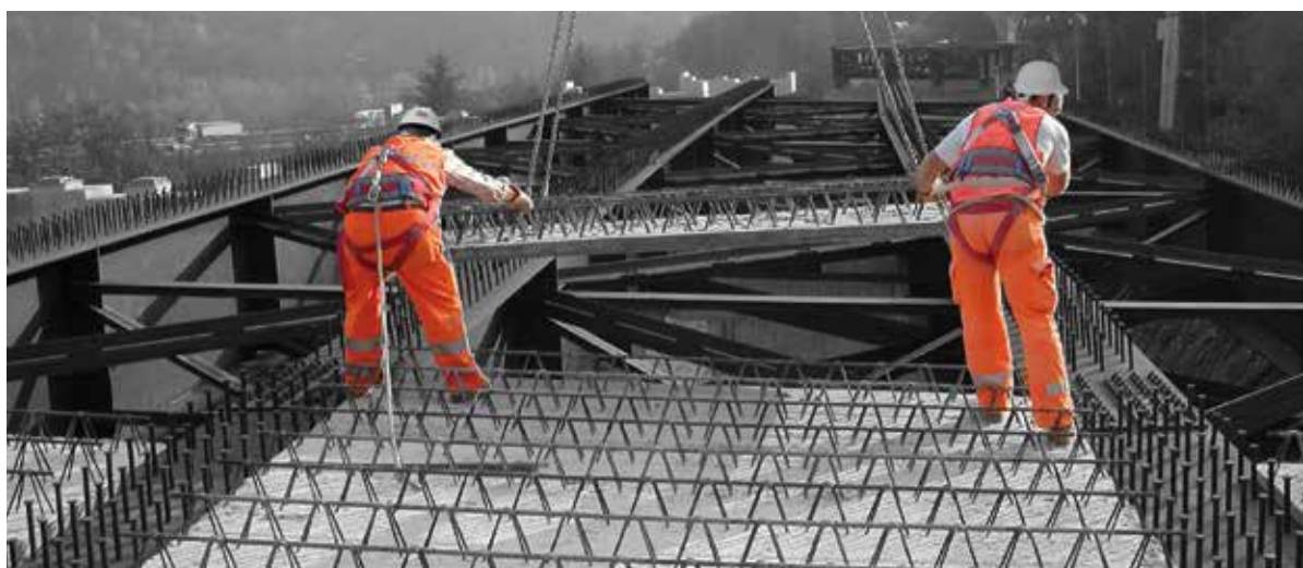
Impalcato del viadotto Campolungo (Emilia Romagna - Italia) - Viaduct Campolungo deck (Emilia Romagna - Italy)
